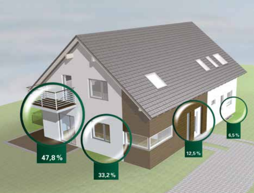
einbruchgefährdete Bereiche am Einfamilienhaus
